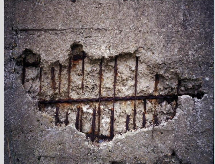
Spalling
